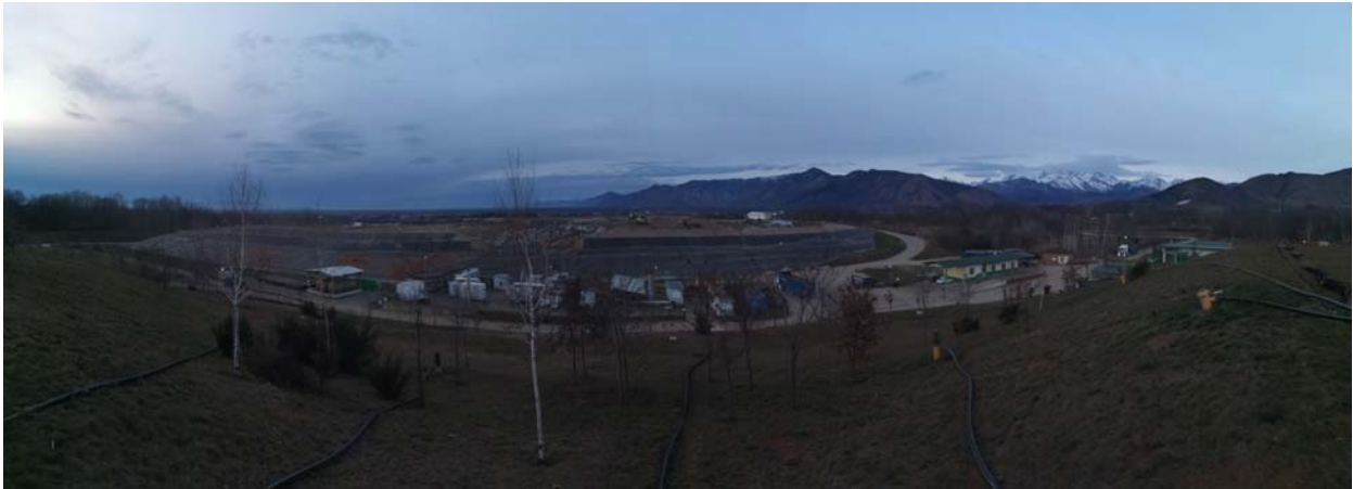
Visione delle lavorazioni del lotto 3 in data 23/01/2023
